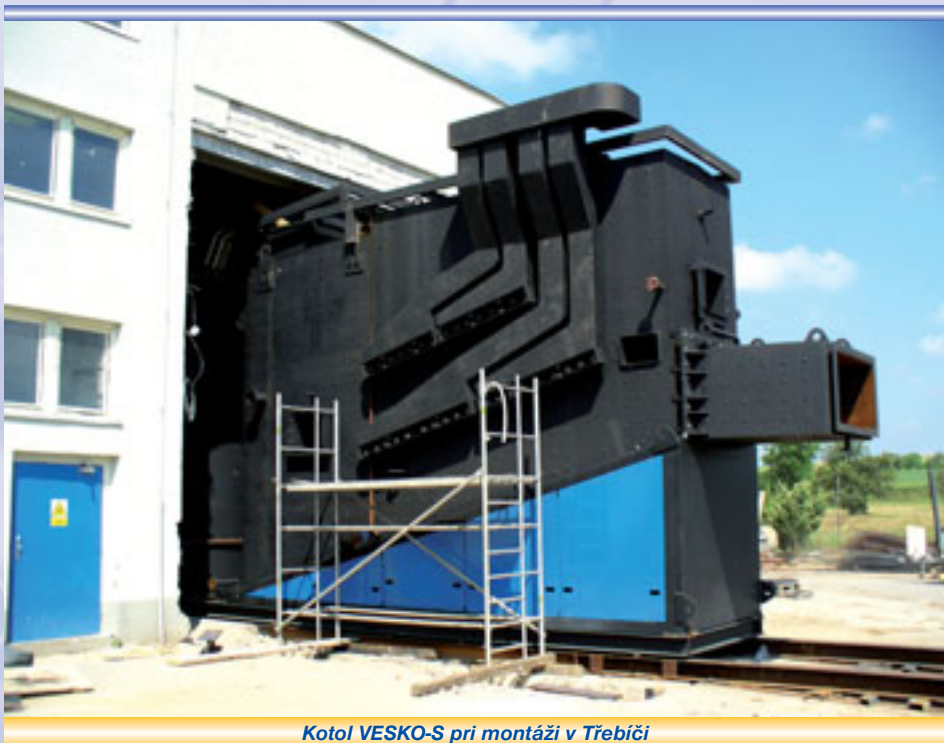
Kotel VESKO-S pri montáži v Třebíči
