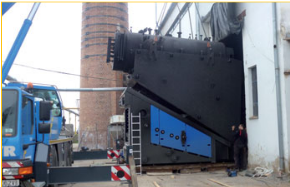
Montáž kotla pred nasunutím do kotolne
