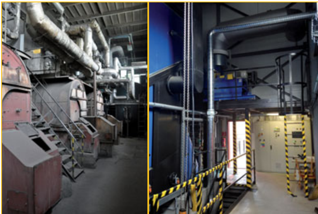
Pôvodný a nový stav kotolne v Tlmačoch
