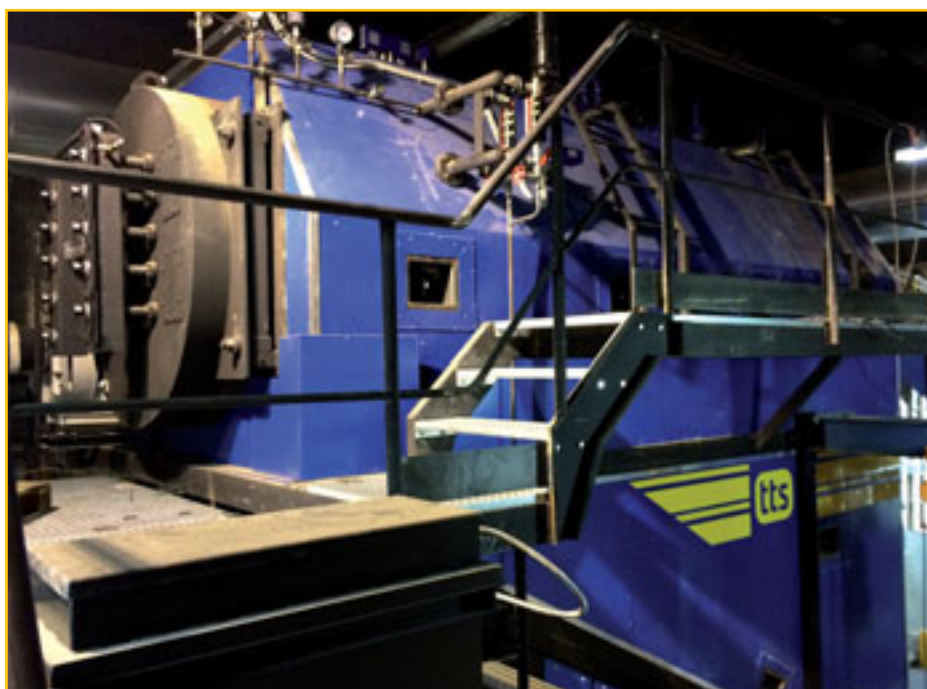
Výmenník kotla s integrovaným čelným čistením výmenníku
