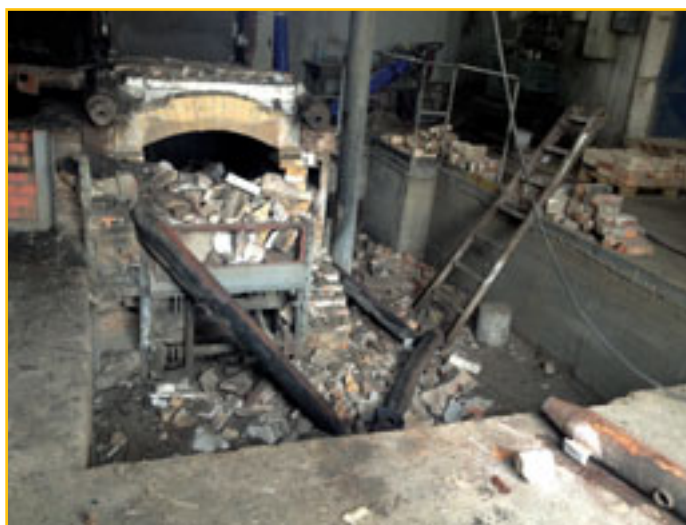
Demoličné práce v kotolni
