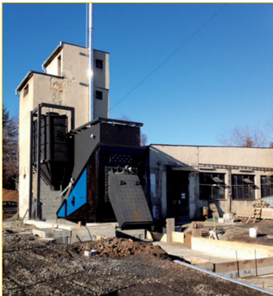
Zmontovaný a osadený kotol
