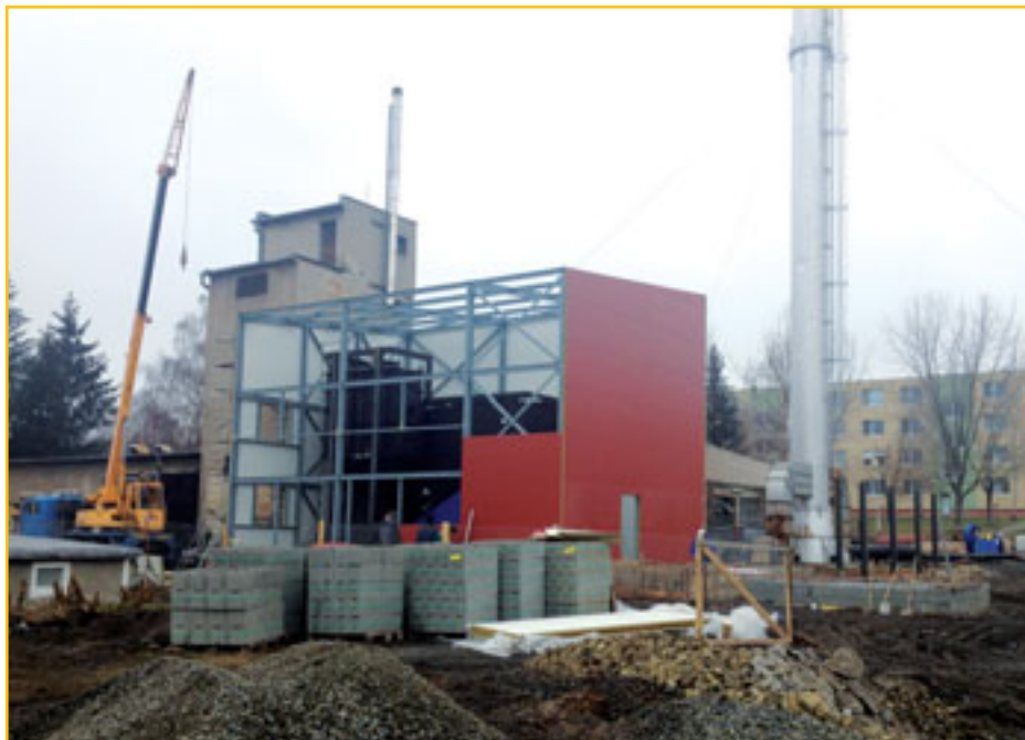
Montáž oceľovej konštrukcie a opláštenia kotla
