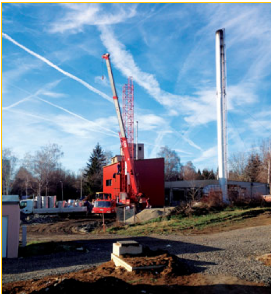
Montáž komínovej konštrukcie
