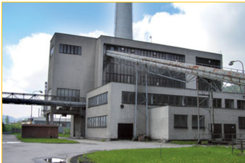
Centrálna kotolňa v Kysuckom Novom Meste
