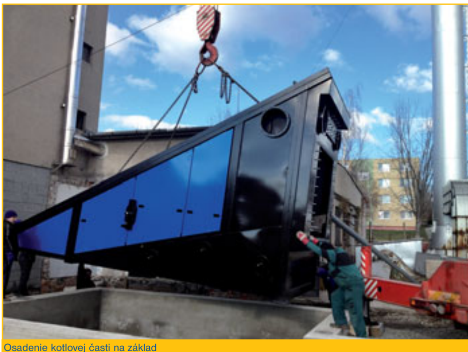
Osadenie kotlovej časti na základ
