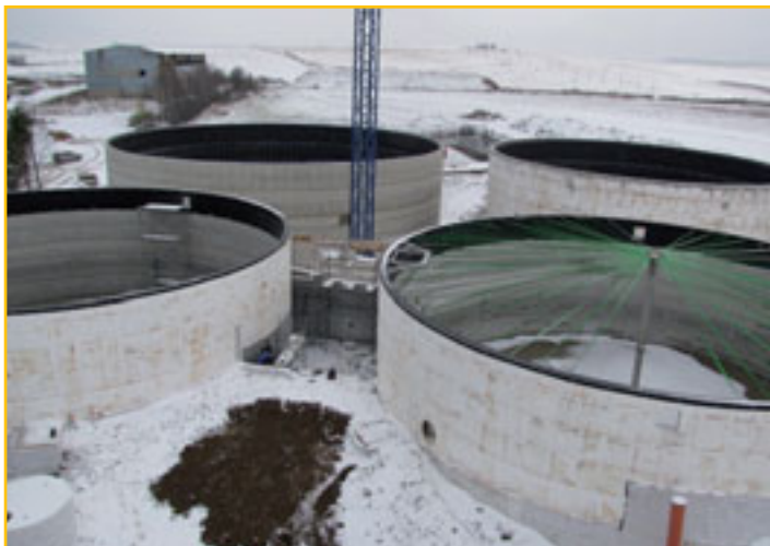
Stav rozpracovanosti k 01.11.2012, Výstavba fermentačných nádrží a skladov
