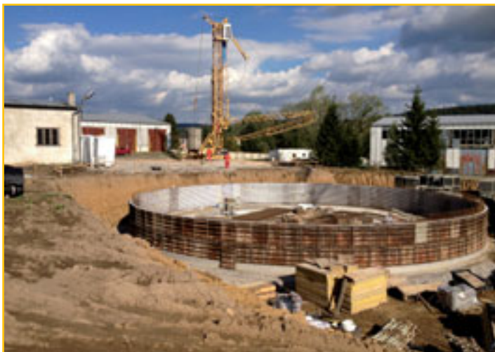
Stav rozpracovanosti k 30.08.2012, Výstavba fermentačných nádrží a skladov Stav rozpracovanosti k 10.09.2012, Výstavba fermentačných nádrží a skladov
