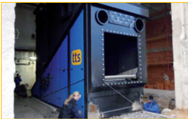
Inštalácia kotla na biomasu
