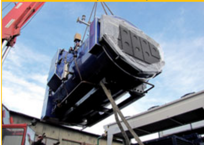
Proces osadenia kogeneračnej jednotky
