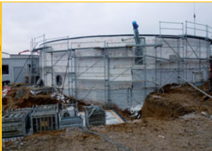
Stav rozpracovanosti k 23.11.2012, Výstavba fermentačných nádrží a skladov
