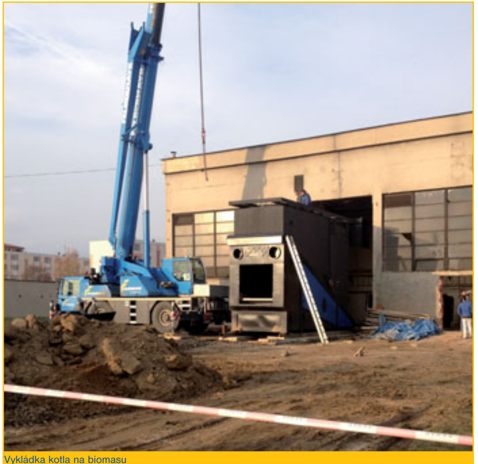
Vykládka kotla na biomasu
