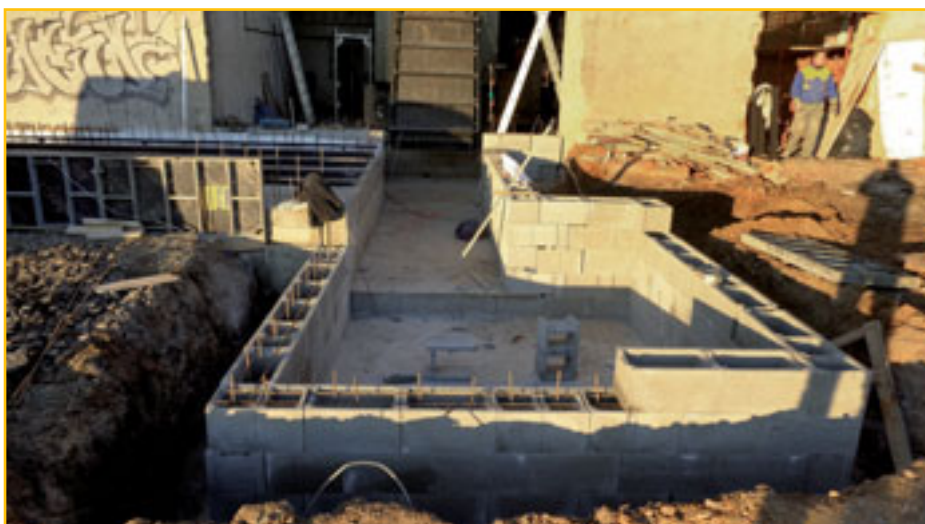
Stavebné práce v Poltári
