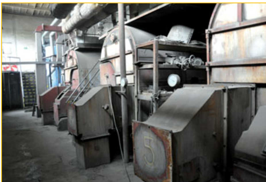
Uhoľná kotolňa v Tlmačoch – pôvodný stav
