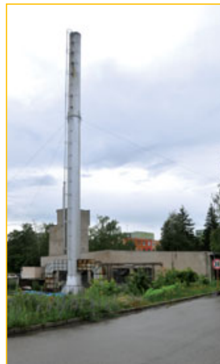
Kotolňa v Tlmačoch – pôvodný stav
