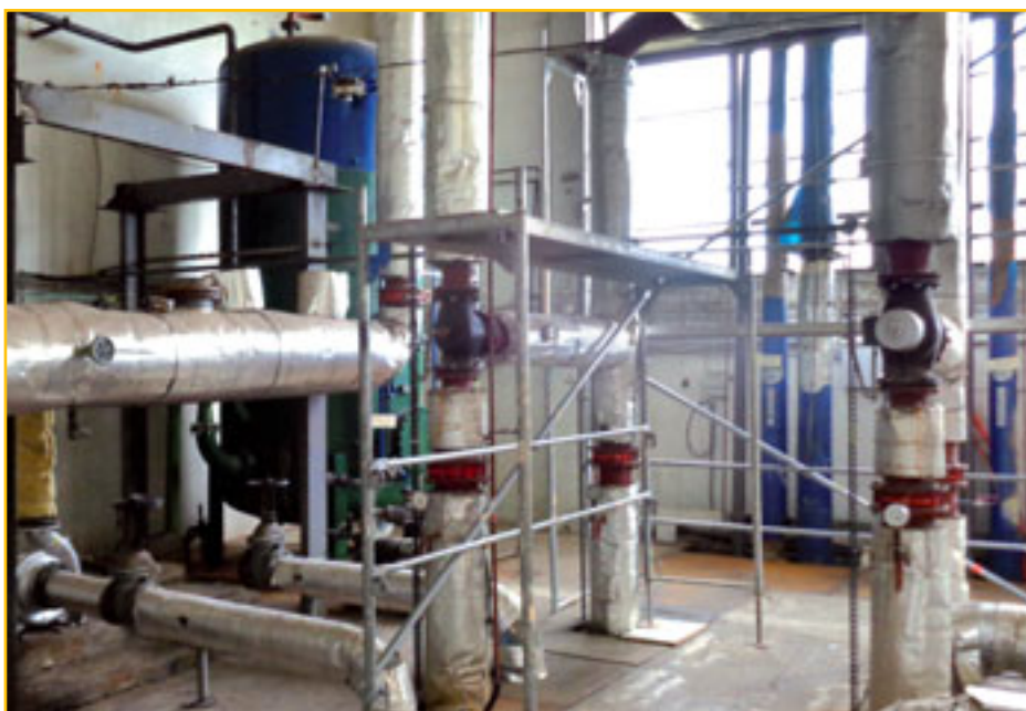
Strojovňa v Poltári – pôvodný stav
