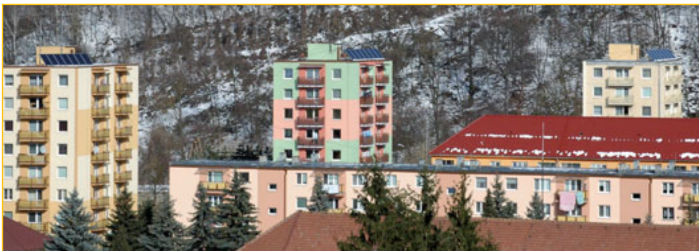
Solárne kolektory v meste Hnúšťa
