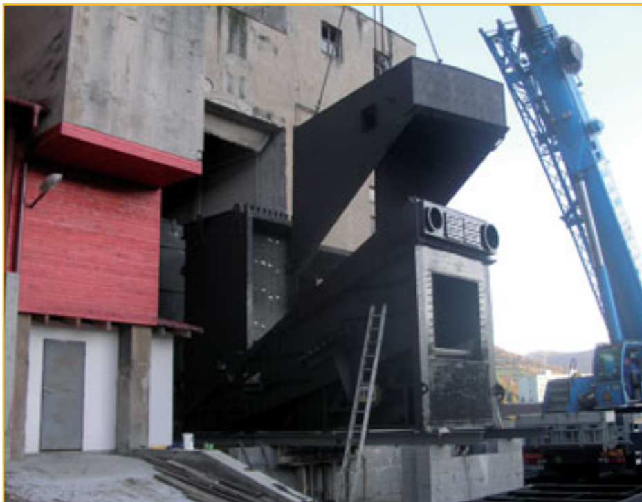
Vykládka kotla na biomasu
