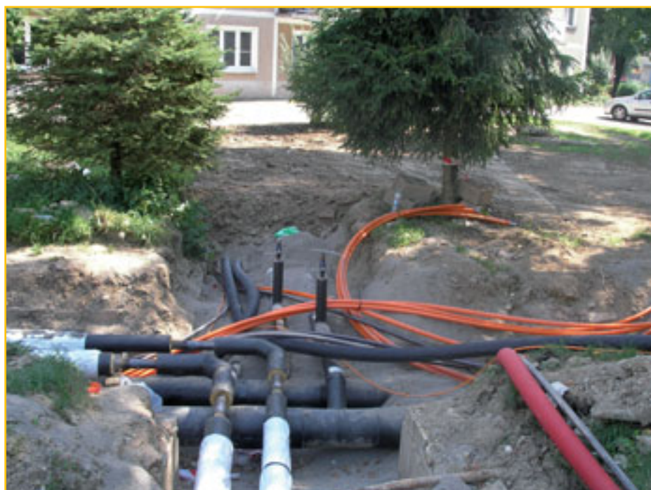
Rozvody v Hriňovej
