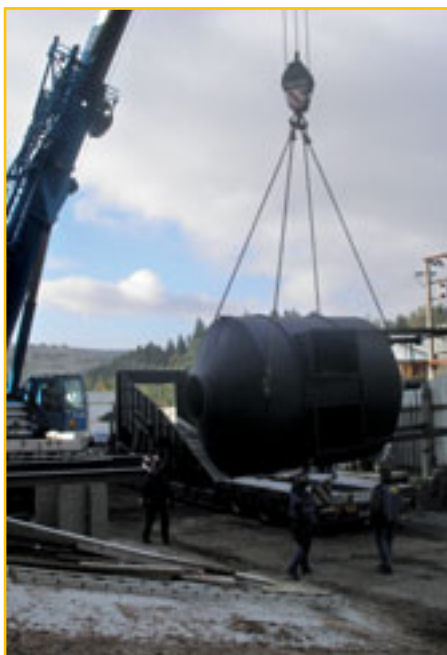
Vykládka kotla na biomasu
