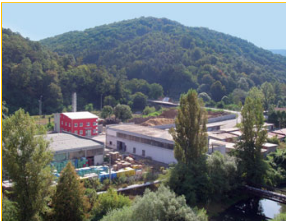
Centrálna kotolňa systému CZT v Hnúšti
