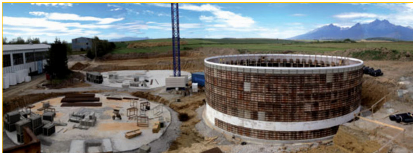
Výstavba bioplynovej stanice v Kežmarku
