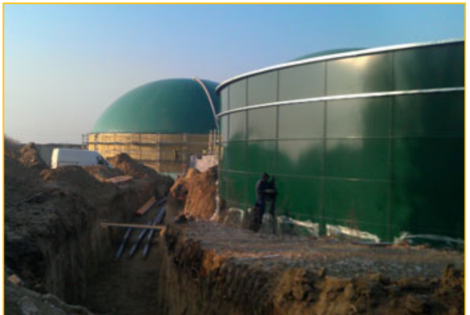
Výstavba bioplynovej stanice
