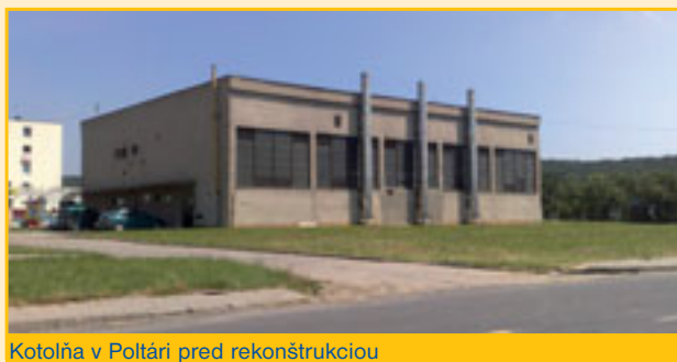
Kotolňa v Poltári pred rekonštrukciou
