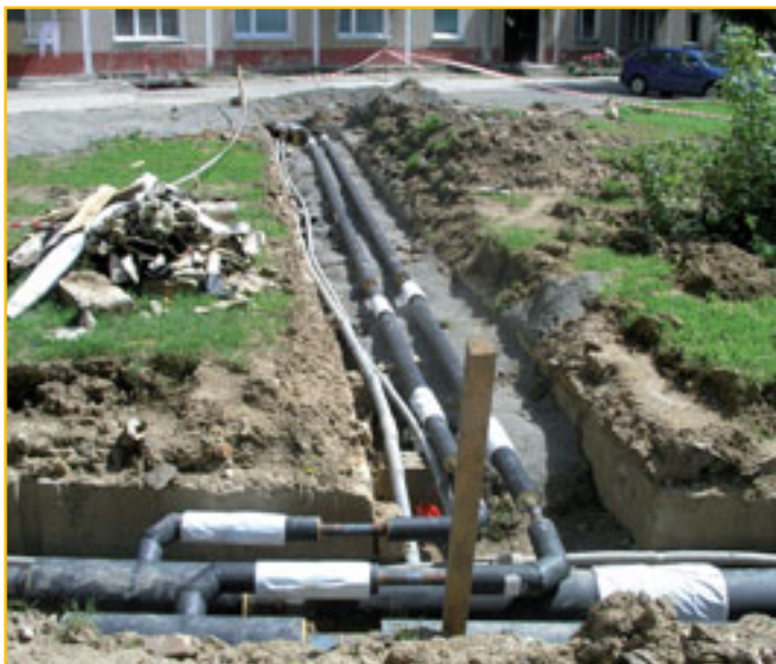
Rekonštrukcia rozvodov tepla v Hriňovej
