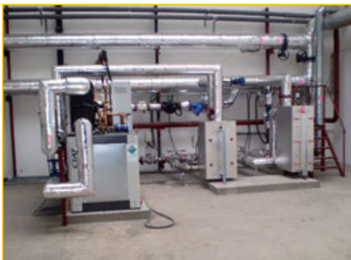
Výmenníky tepla a tepelné čerpadlo
