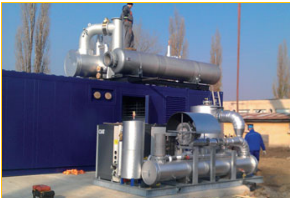
Montáž kogeneračnej jednotky
