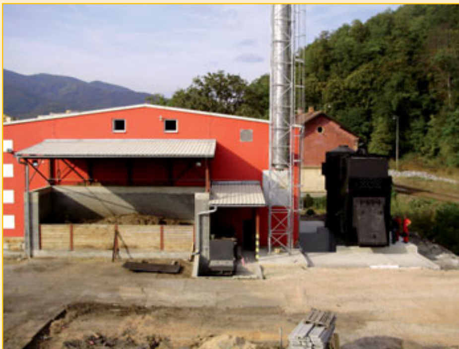
Rozširovanie kotolne v Hnúšti o nový kotol VESKO-B
