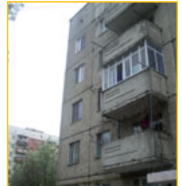
Komín z každého bytu
