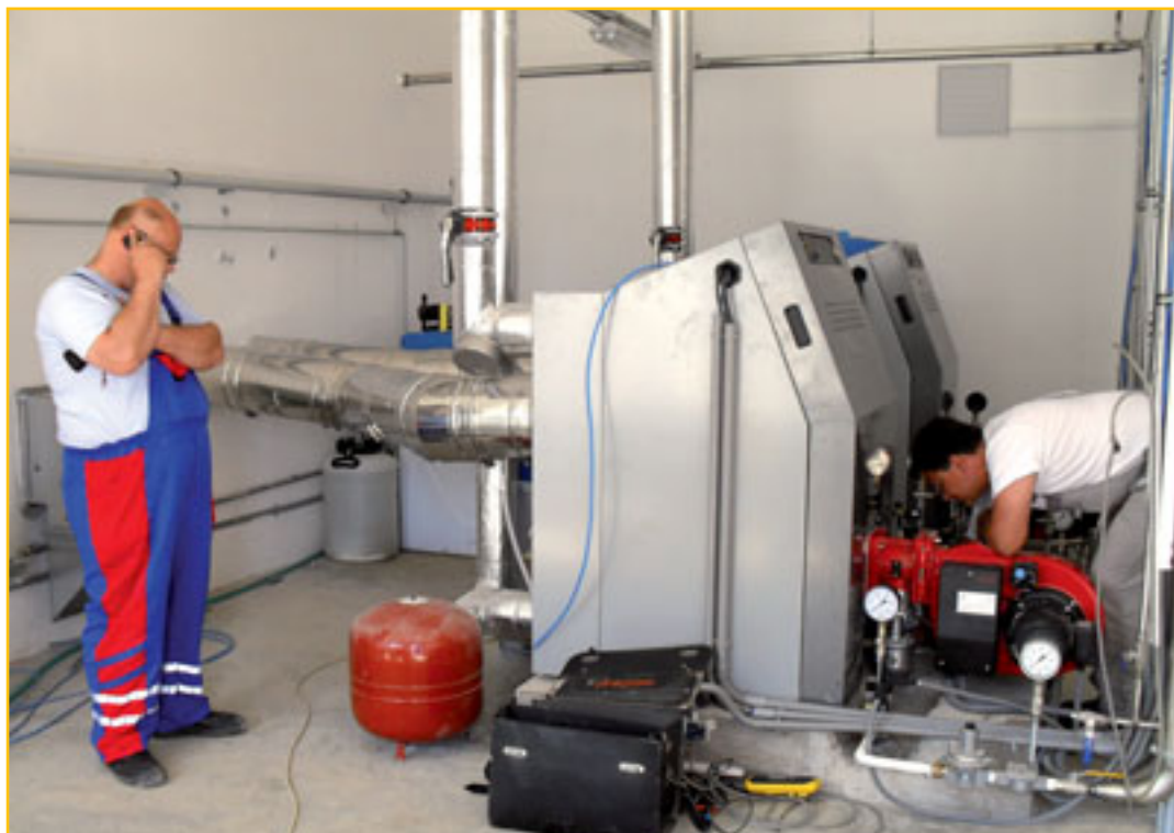
Výstavba plynovej kotolne – bioplyn / zemný plyn
