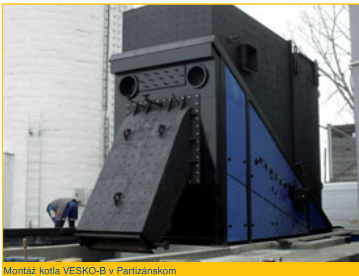
Montáž kotla VESKO-B v Partizánskom
