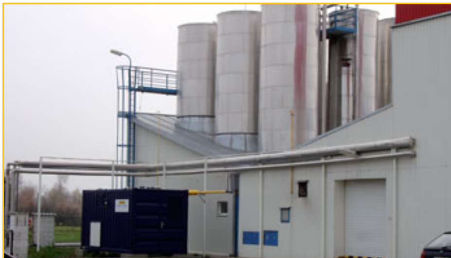
Kogeneračná jednotka TEDOM v kontajnerovej verzii v spoločnosti JAV AKC vo Vlčanoch
