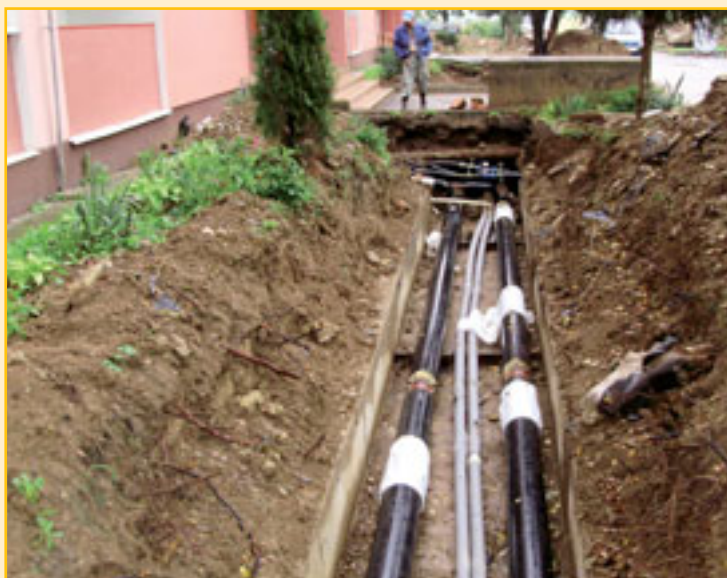
Výstavba rozvodov tepla v Poltári
