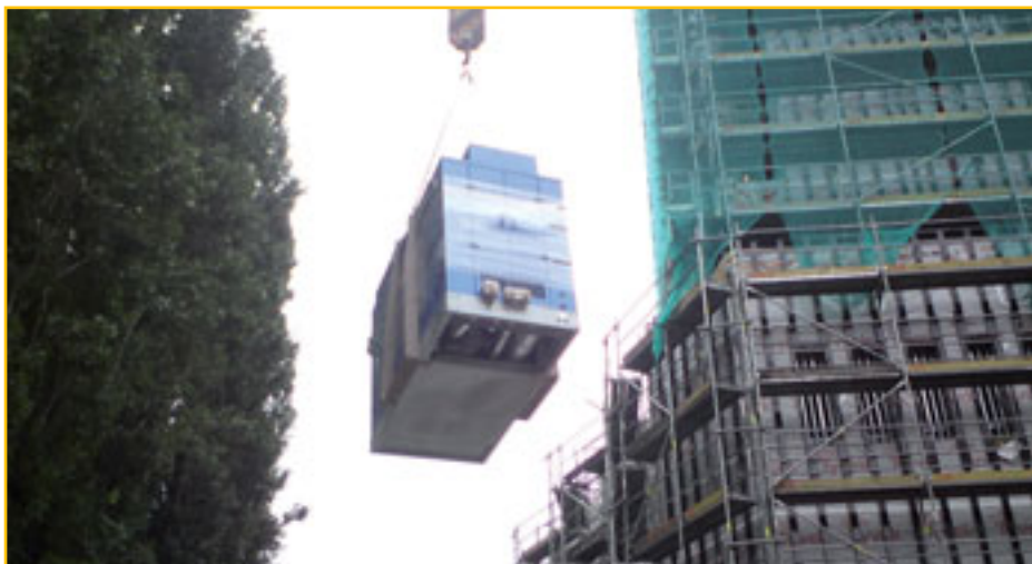
Umiestňovanie kogeneračnej jednotky do tretieho podlažia
