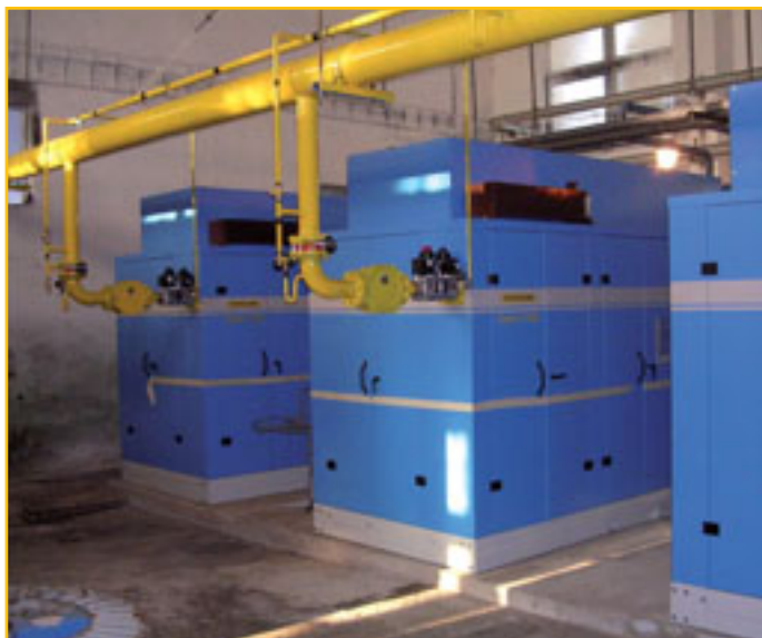
Kogeneračné jednotky TEDOM na bioplynovej stanici
