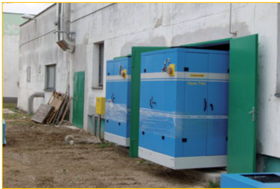
Umiestňovanie kogeneračných jednotiek TEDOM
