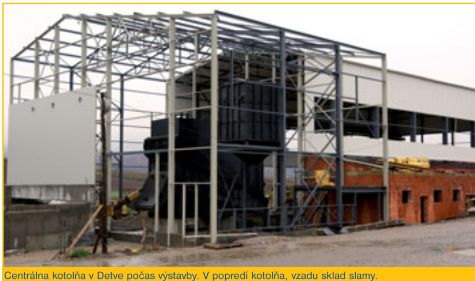
Centrálna kotolňa v Detve počas výstavby. V popredí kotolňa, vzadu sklad slamy.
