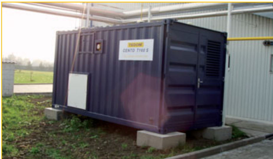
Kogeneračná jednotka TEDOM Cento T 160 S v kontajnerovej verzii
