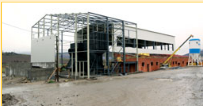
Výstavba kotolne na biomasu v Detve
