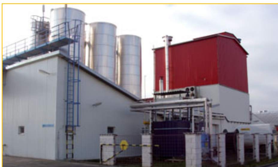
Výrobná prevádzka spoločnosti JAV-AKC, s.r.o. Vlčany
