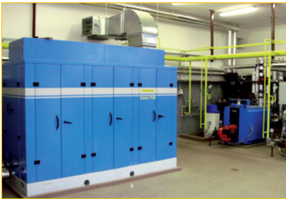
Kogeneračná jednotka TEDOM Cento T 120 SP BIO v Humennom
