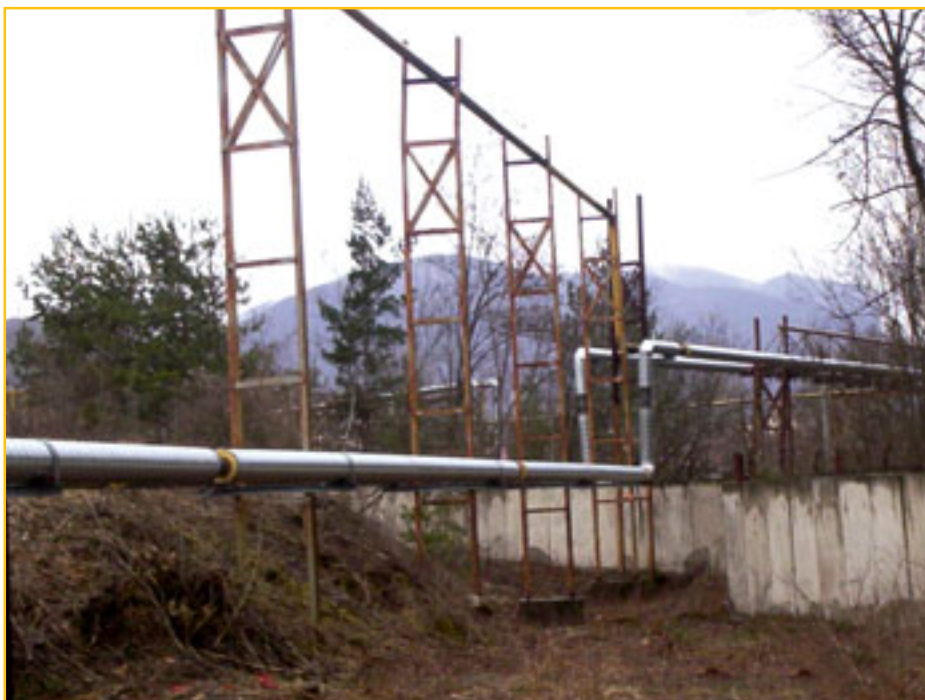
Teplovodný prepoj priemyselného parku a centrálnej kotolne na biomasu
