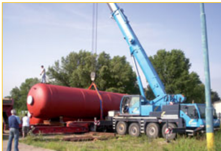
Akumulčné nádrže pri výstavbe
