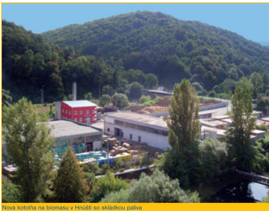
Nová kotolňa na biomasu v Hnúšti so skládkou paliva
