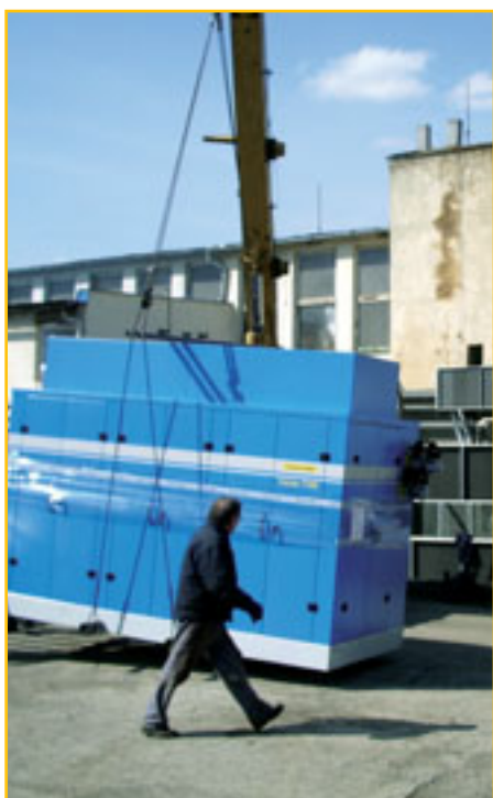
Vykładka kogeneračnej jednotky v Kapušanoch
