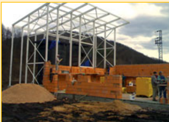
Výstavba kotolne na biomasu v Hnúšti
