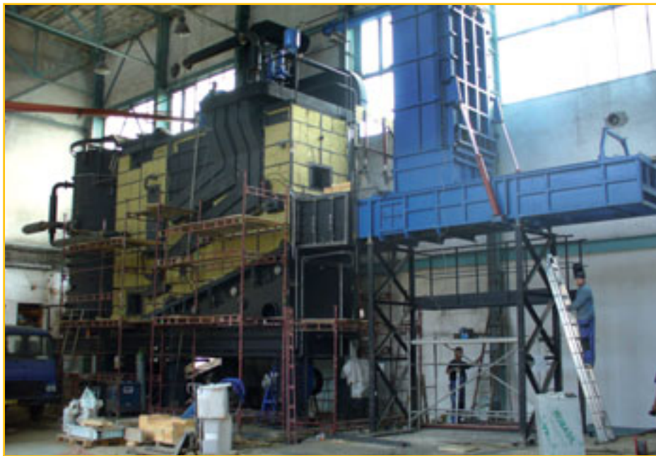
Jeden z kotlov VESKO-S počas výstavby
