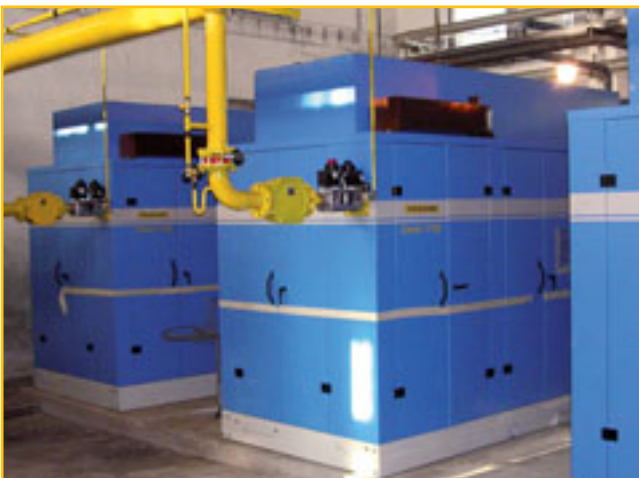
Kogeneračné jednotky TEDOM spaľujúce bioplyn
