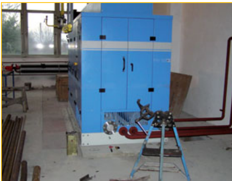
Kogeneračná jednotka TEDOM Cento T150 SP BIO na ČOV Martin – Vrútky
