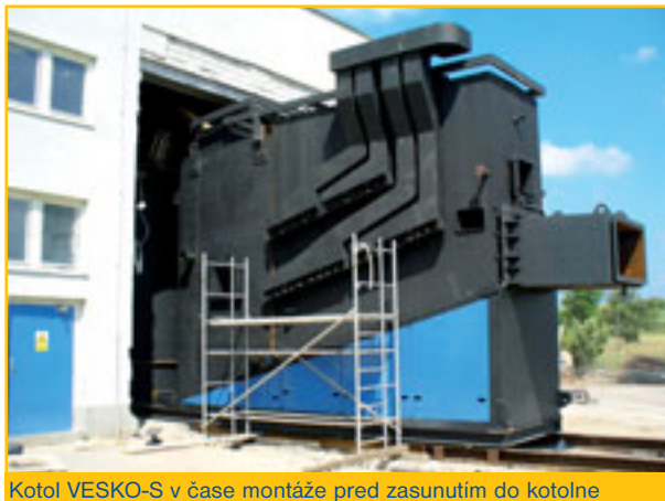
Kotol VESKO-S v čase montáže pred zasunutím do kotolne
