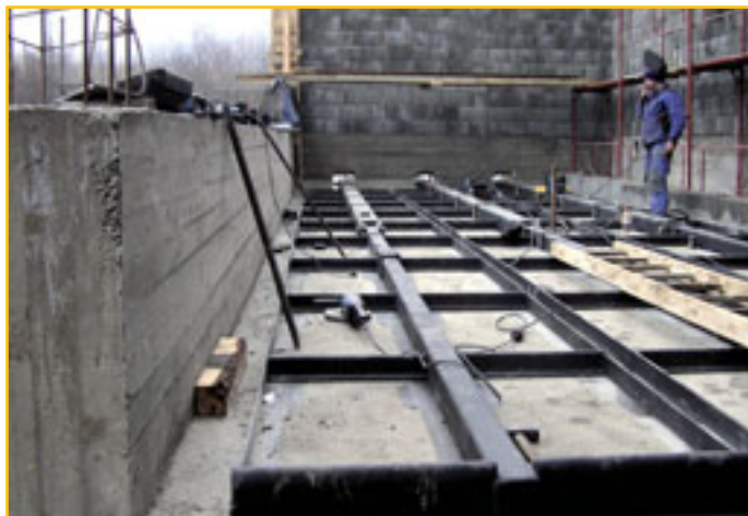
Práce na dennom zásobníku paliva
