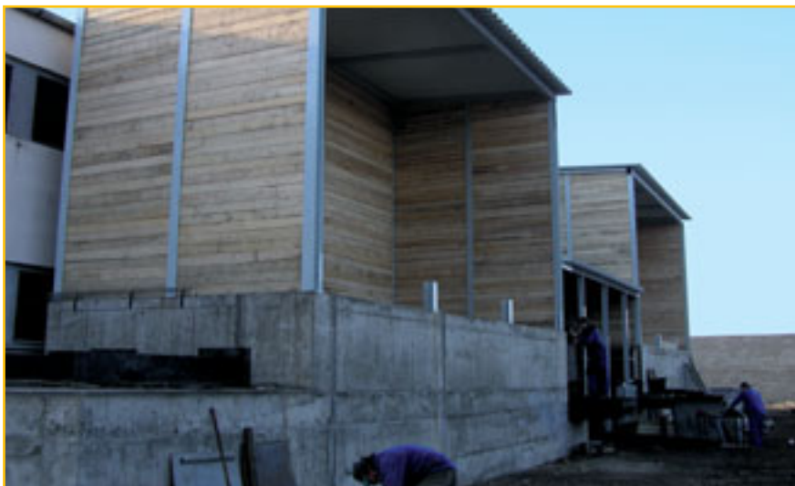
Dokončovacie práce v Malackách
