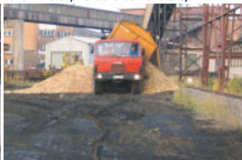
15. 10. – prvé palivo na skládke
