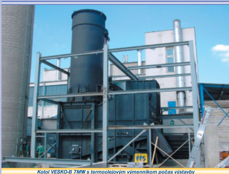
Kotol VESKO-B 7MW s termoolejovým výmenníkom počas výstavby
