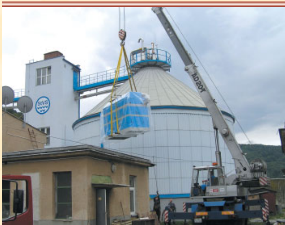
Vykládka kogeneračnej jednotky TEDOM Cento T150 SP BIO na ČOV Zvolen
