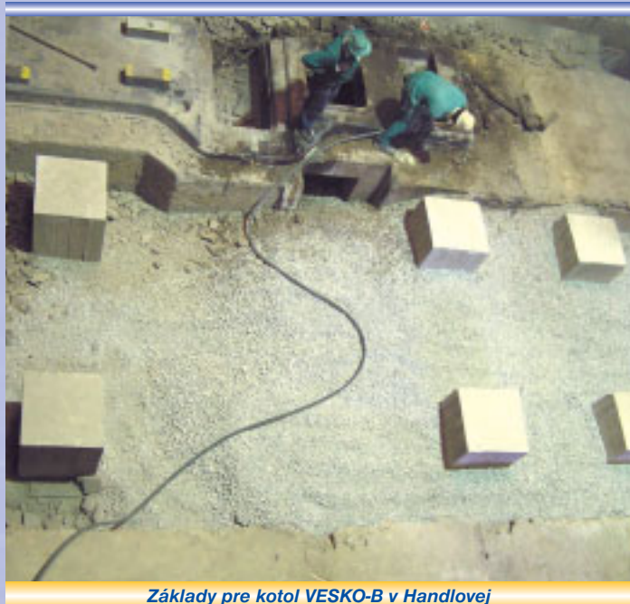
Základy pre kotol VESKO-B v Handlovej
