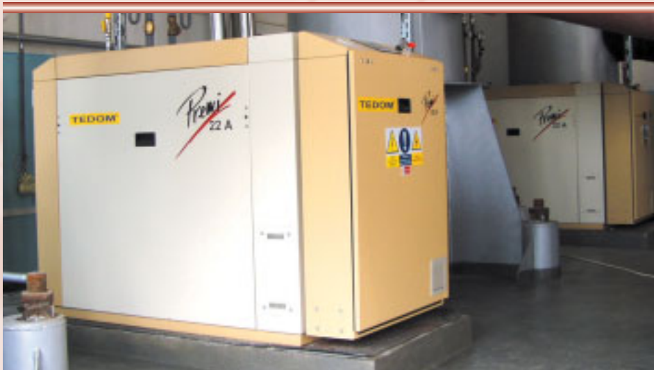
Kogeneračné jednotky TEDOM Premi S22 v Bánovciach nad Bebravou
