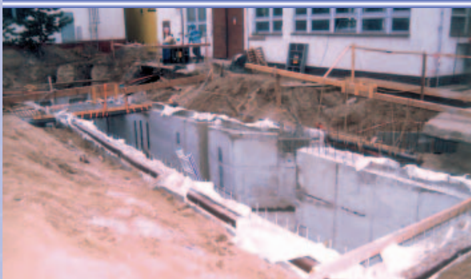
Súčasťou projektu je aj výstavba kolektora, nad ktorým bude umiestnená kogeneračná jednotka
