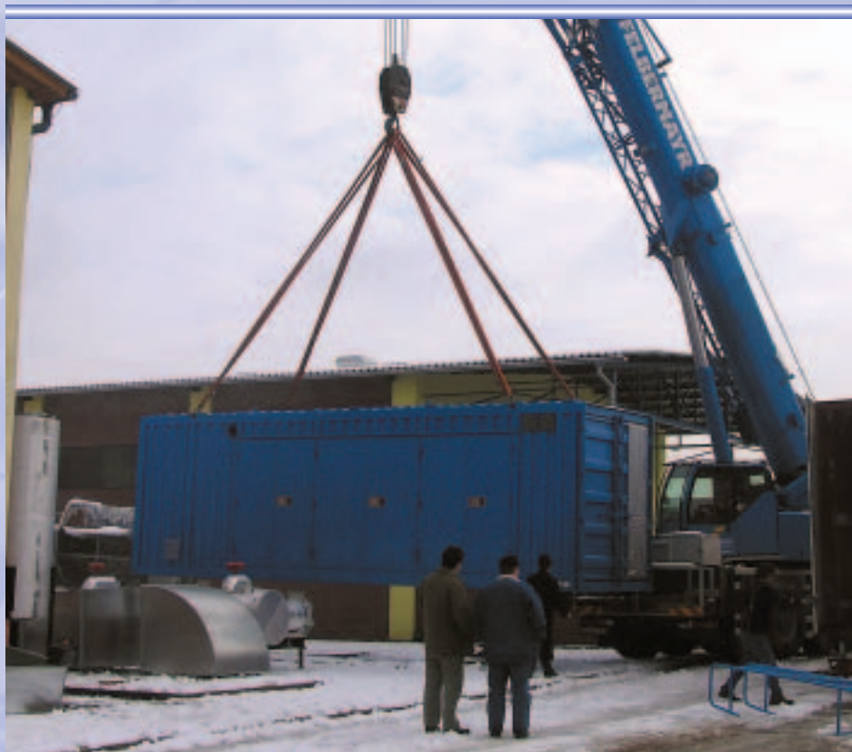
Kogeneračná jednotka TEDOM Quanto W500 SPE počas vykládky
