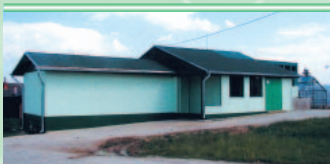
Budova bioplynovej stanice
