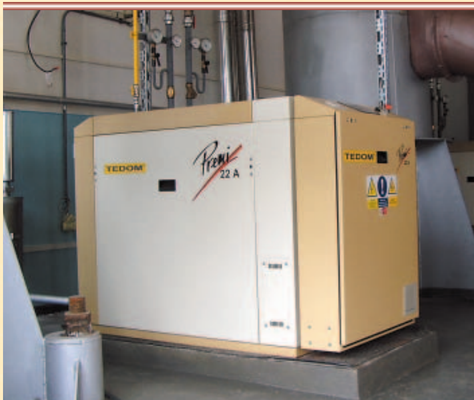
Kogeneračná jednotka TEDOM Premi S22AP v Bánovciach nad Bebravou
