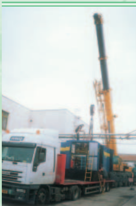
Vykládka kogeneračnej jednotky
