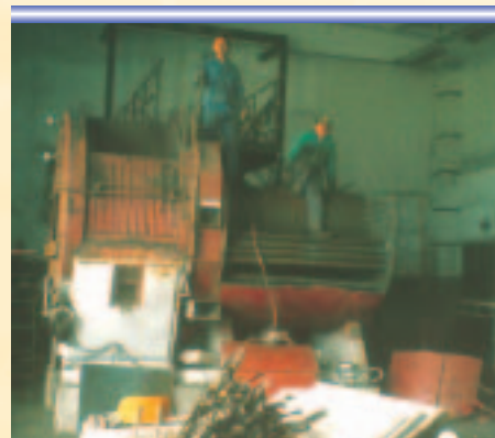
Demontáž starej kotolne
