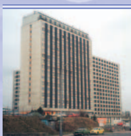
Bytový dom s kogeneračnou jednotkou
