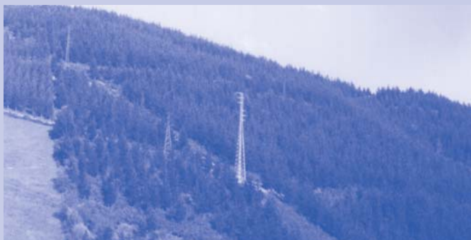
Pohľad na miesto inštalácie
