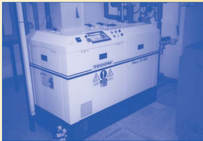
Kogeneračná jednotka TEDOM Plus 10 SPE inštalovaná v tomto roku v chate OREŠNICA v Račkovej doline
