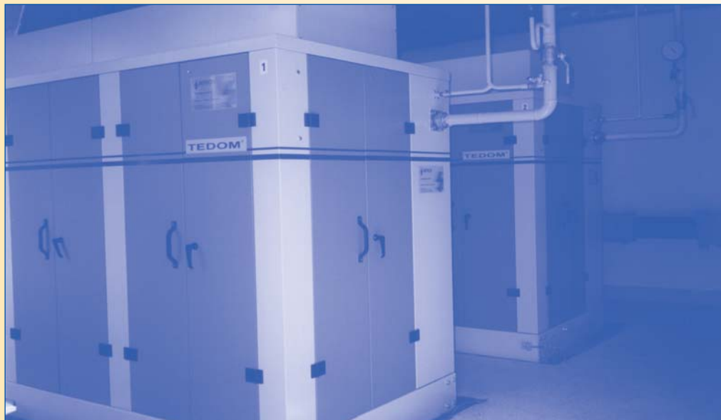
Kogeneračné jednotky TEDOM MT 140 SP v NsP Humenné
