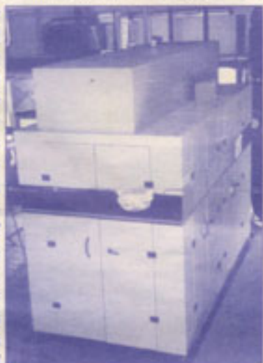
Kogeneračná jednotka TEDOM CAT 190 vo vranovskej nemocnici
