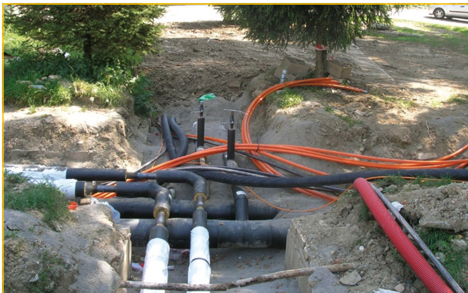
Заміна труб гарячого водопостачання в Гриньовій
