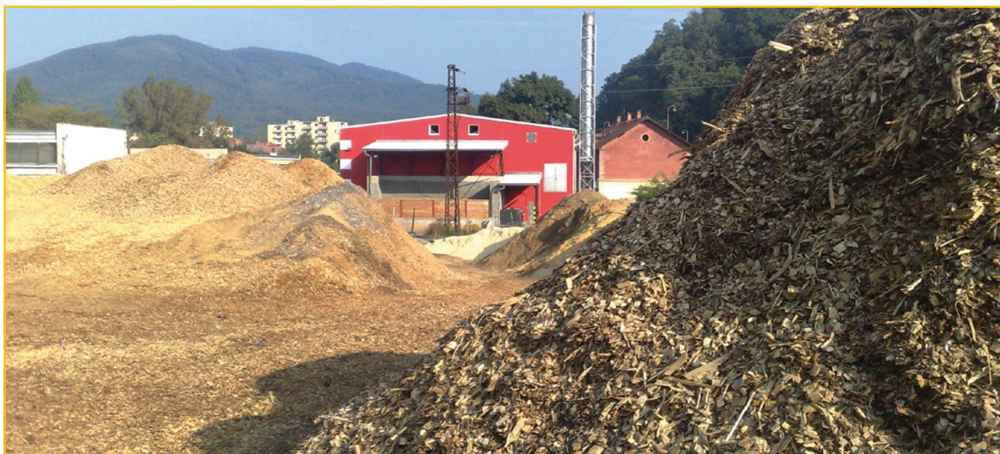
Котельня для біомаси в Гнушті
