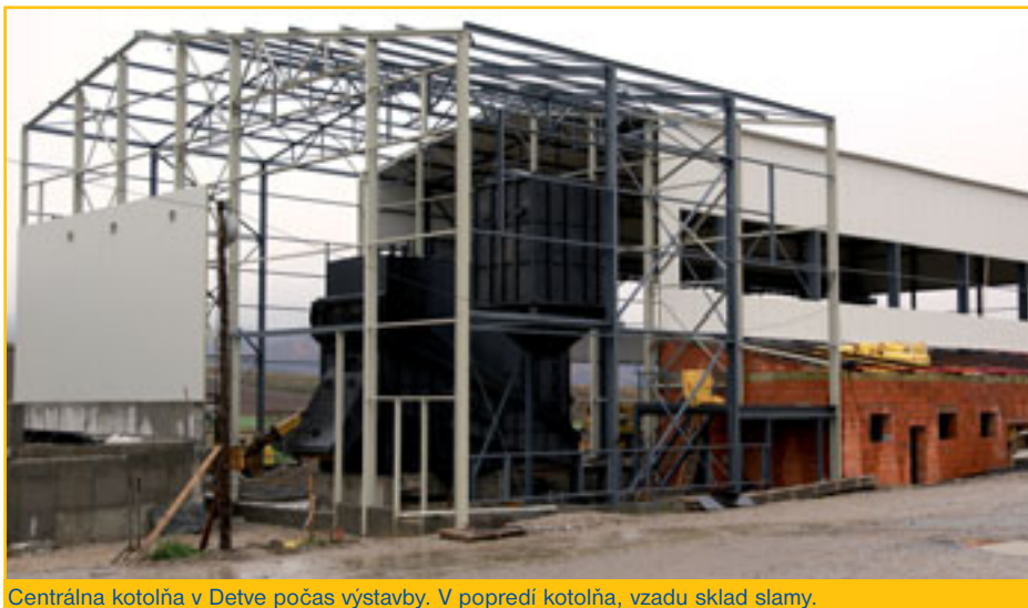
Centrálna kotelňa v Detve počas výstavby. V popredí kotelňa, vzadu sklad slamy.
