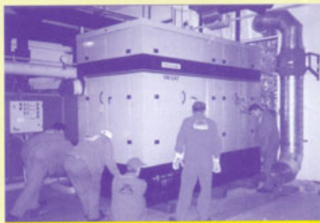
Umiestňovanie kogeneračnej jednotky v kotolni MECOMu
