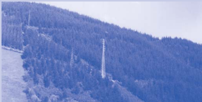
Pohľad na miesto inštalácie
